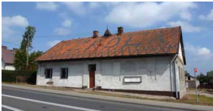
Budynek starej szkoły w Nienadówce. Stan przed rozbiórką w 2015 roku
