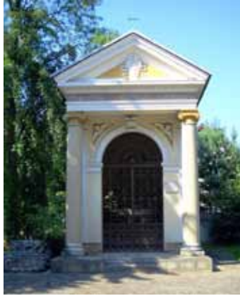
Kaplica grobowa Jędrzejowiczów
